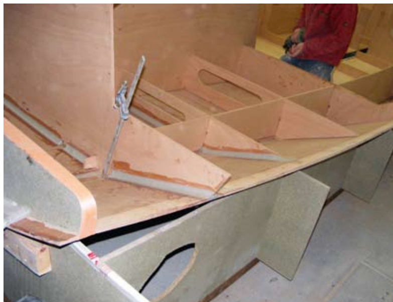
C'est parti ! Les premières pièces structurelles sont stratifiées et collées à la résine époxy à la coque.
