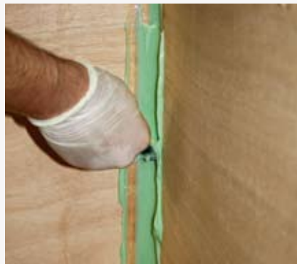
Il applique le mélange au racleur pour former un joint bien arrondi dans l'angle.
