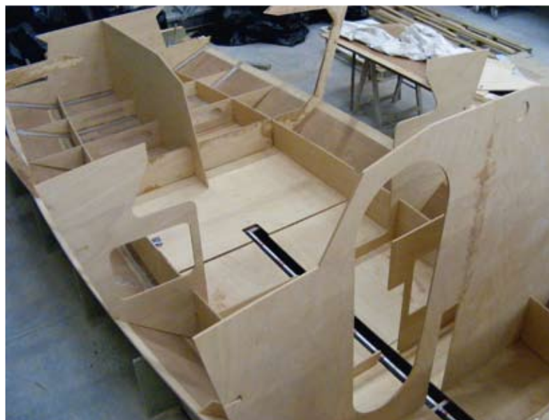
Une fois la forme et le bouchain définitifs, le chantier a posé à blanc (c'est-à-dire pour de faux) les cloisons structurelles pour contrôler l'imbrication.
