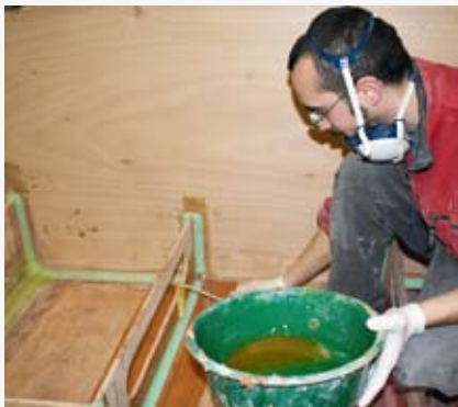
Après séchage et aspiration, badigeonnage de résine dans la zone à corniéragé.
